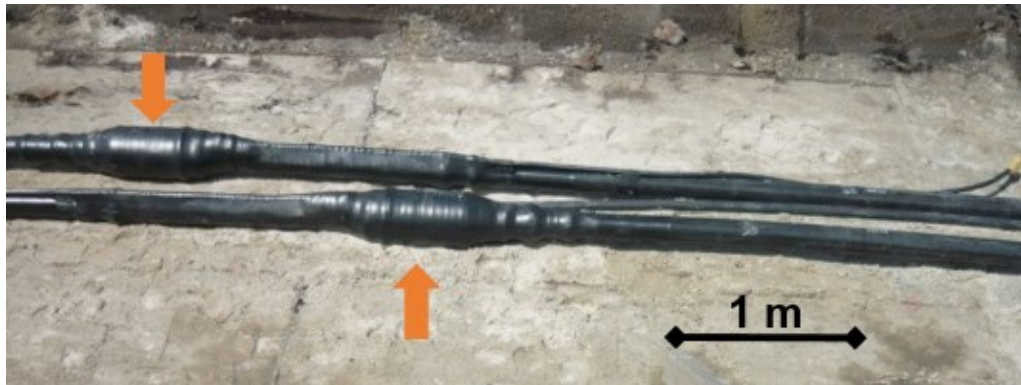
Abbildung 7: Muffen (Pfeilmarkierung) vor Wiederverfüllung des Leitungsgrabens 7
